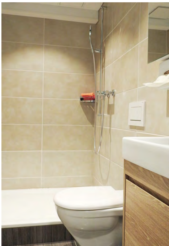
Praxisraum im EG: Dusche - WC
